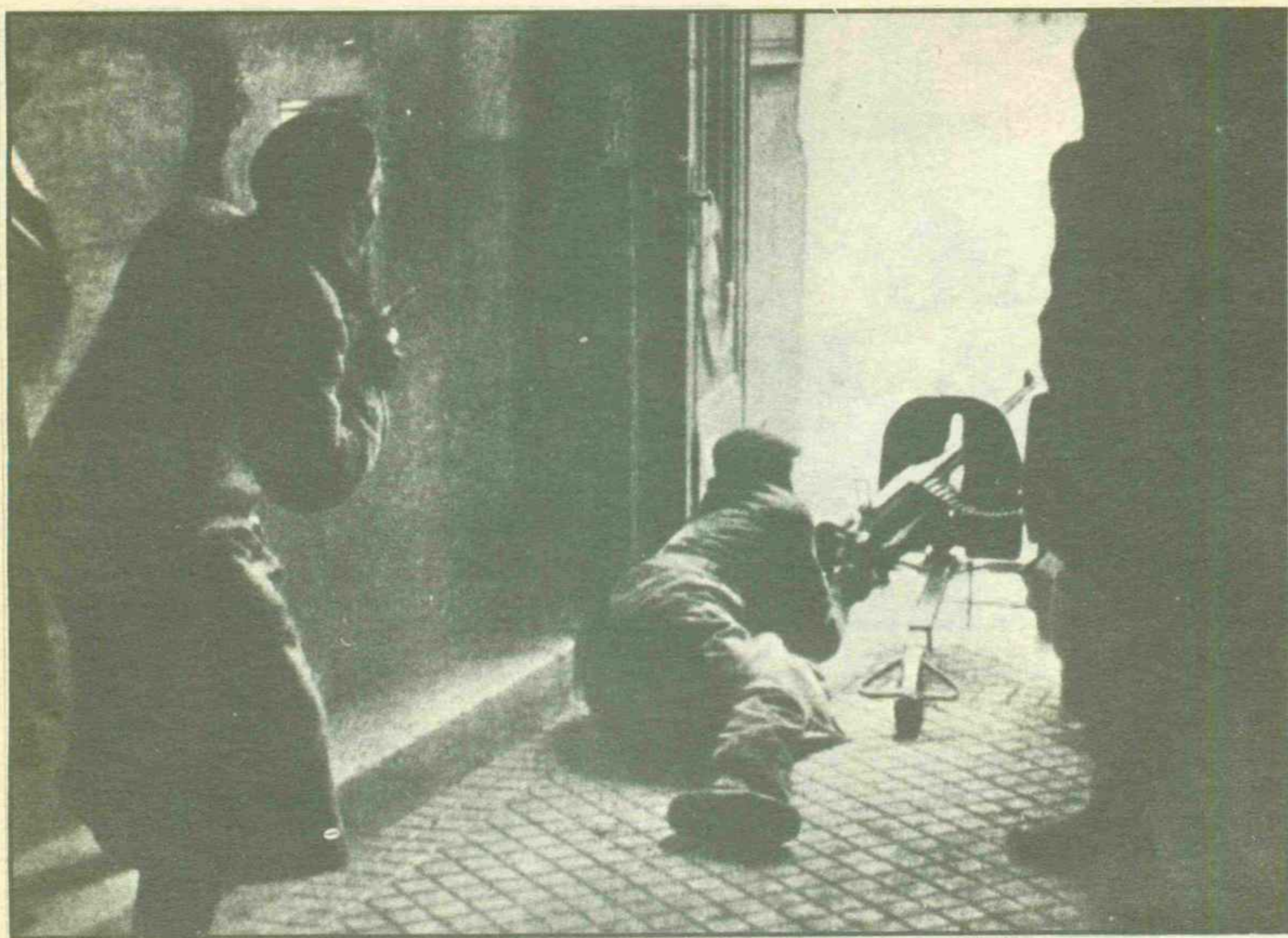
La lucha conoce todas las variantes del conflicto urbano. En la imagen, puesto improvisado de ametralladora situado en el portal de un edificio de viviendas.
