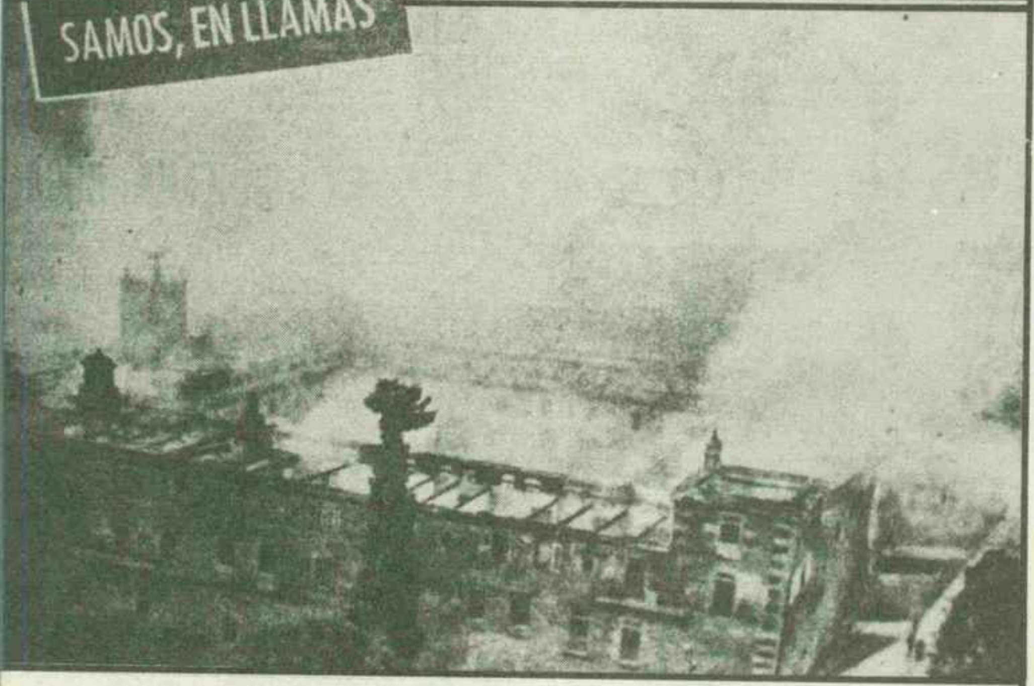
Ofrecemos en esta página dos fotografías del incendio del Real Monasterio Benedictino de Samos, Lugo, captadas en la tarde del lunes último, antes de su total destrucción por las llamas. (Fotos José Penela Castedo.)
