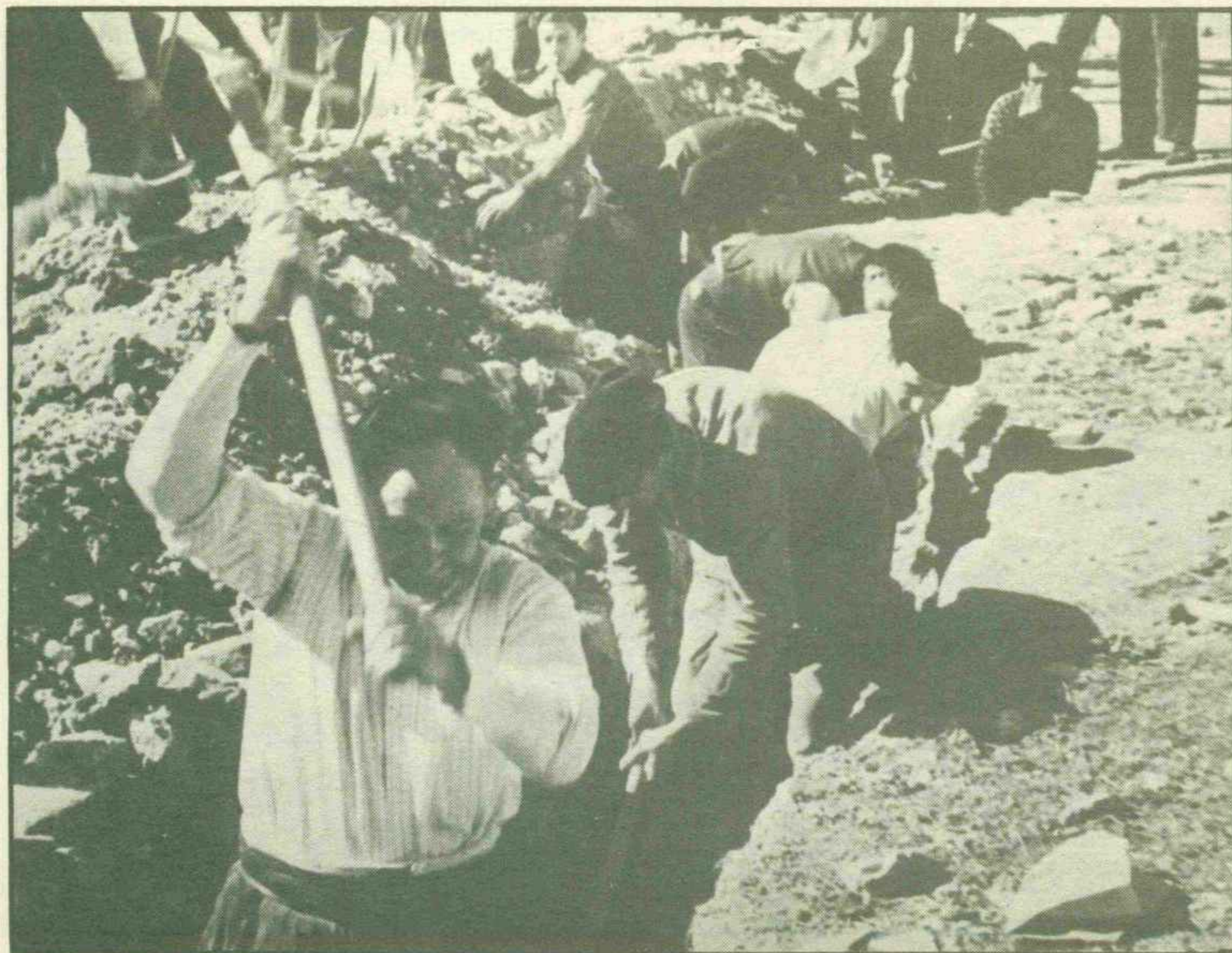
Cavando trincheras para la defensa de Madrid. En esta tarea colaboró toda la población de la capital, durante los primeros meses de la guerra civil.
