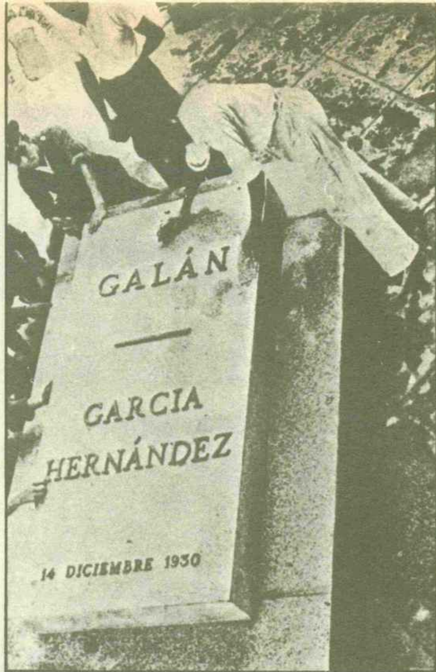
La lápida sepulcral de los capitanes Galán y García Hernández, que en los primeros días de la II República se pensó colocar en la Puerta de Alcalá.
