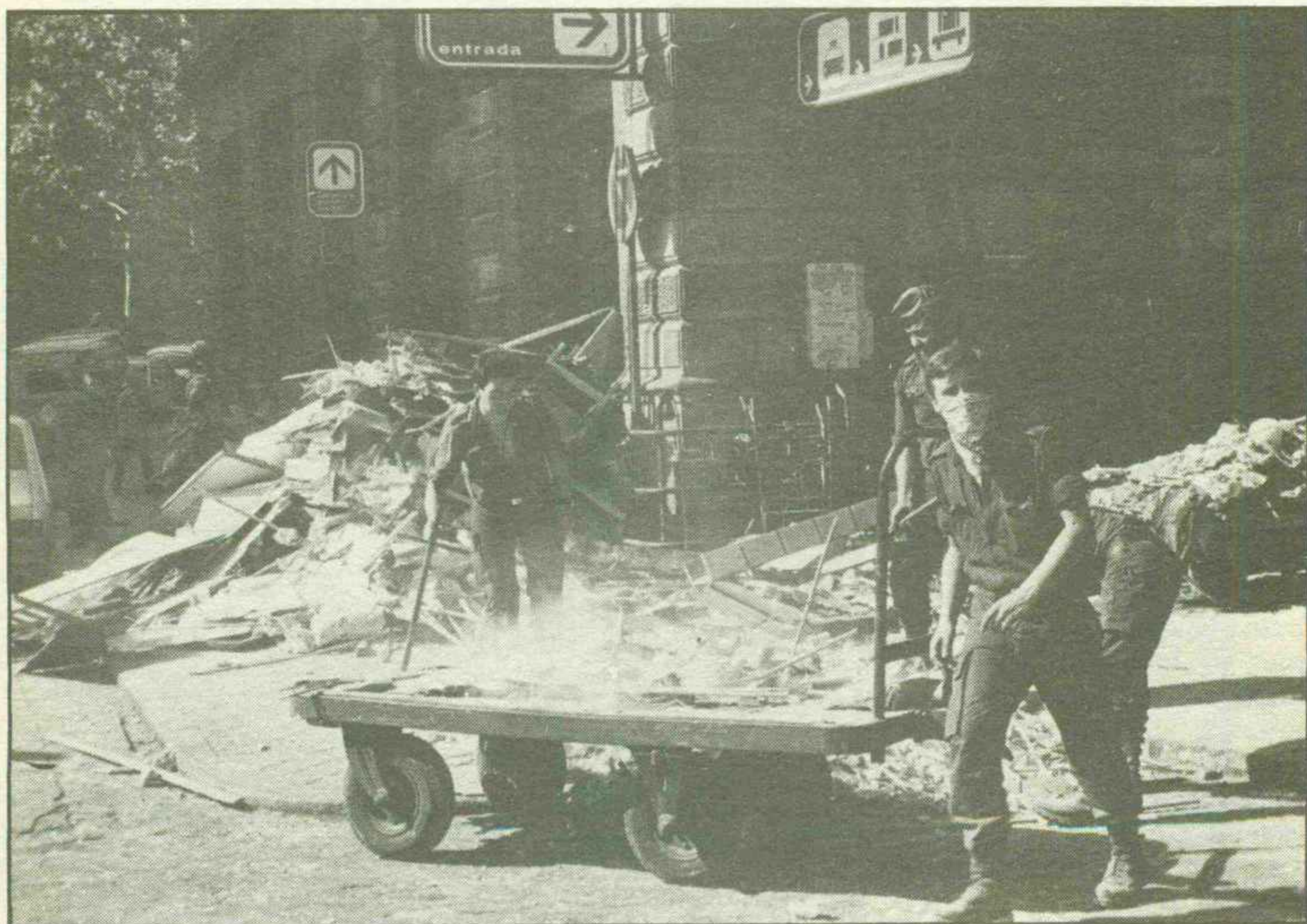
Destrozos causados por un artefacto en el vestíbulo de la estación de ferrocarril de Atocha, de Madrid, en julio de 1979, causando cinco muertos y varios heridos.
