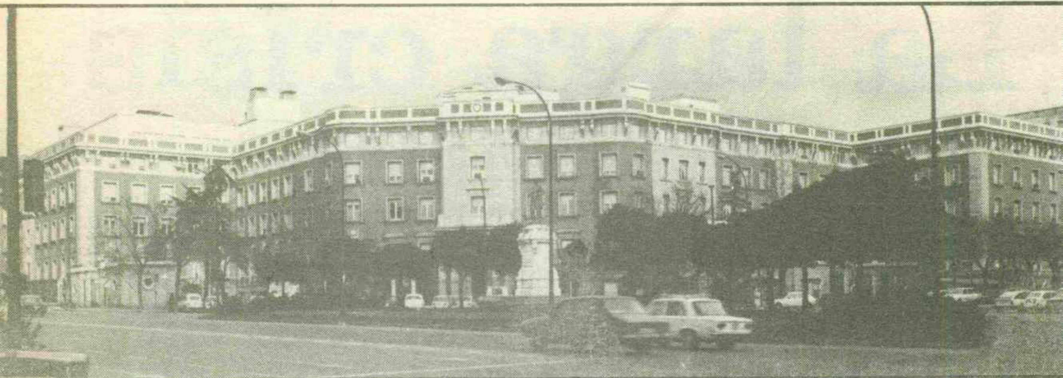
El edificio del INI (Instituto Nacional de Industria), en Madrid.
