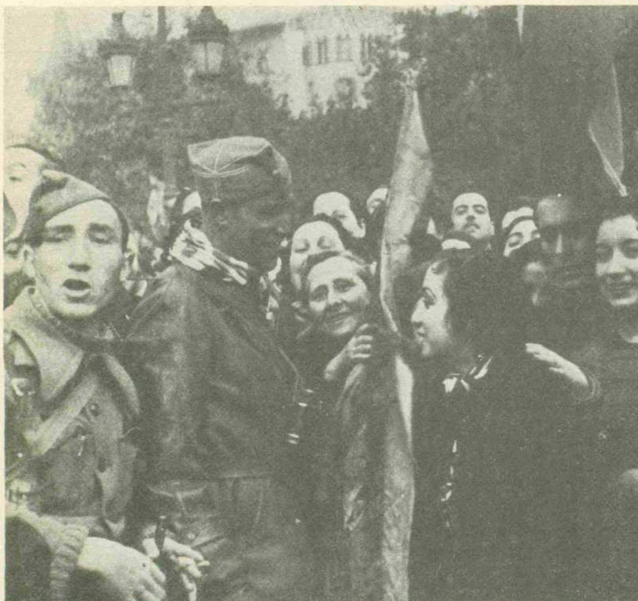
La derrota de la República en 1939 destruyó toda esperanza de emancipación para la mujer en un futuro próximo. Sin embargo, dentro de la burguesía especialmente, muchas acogieron a las tropas franquistas con entusiasmo, como muestra esta imagen barcelonesa.
