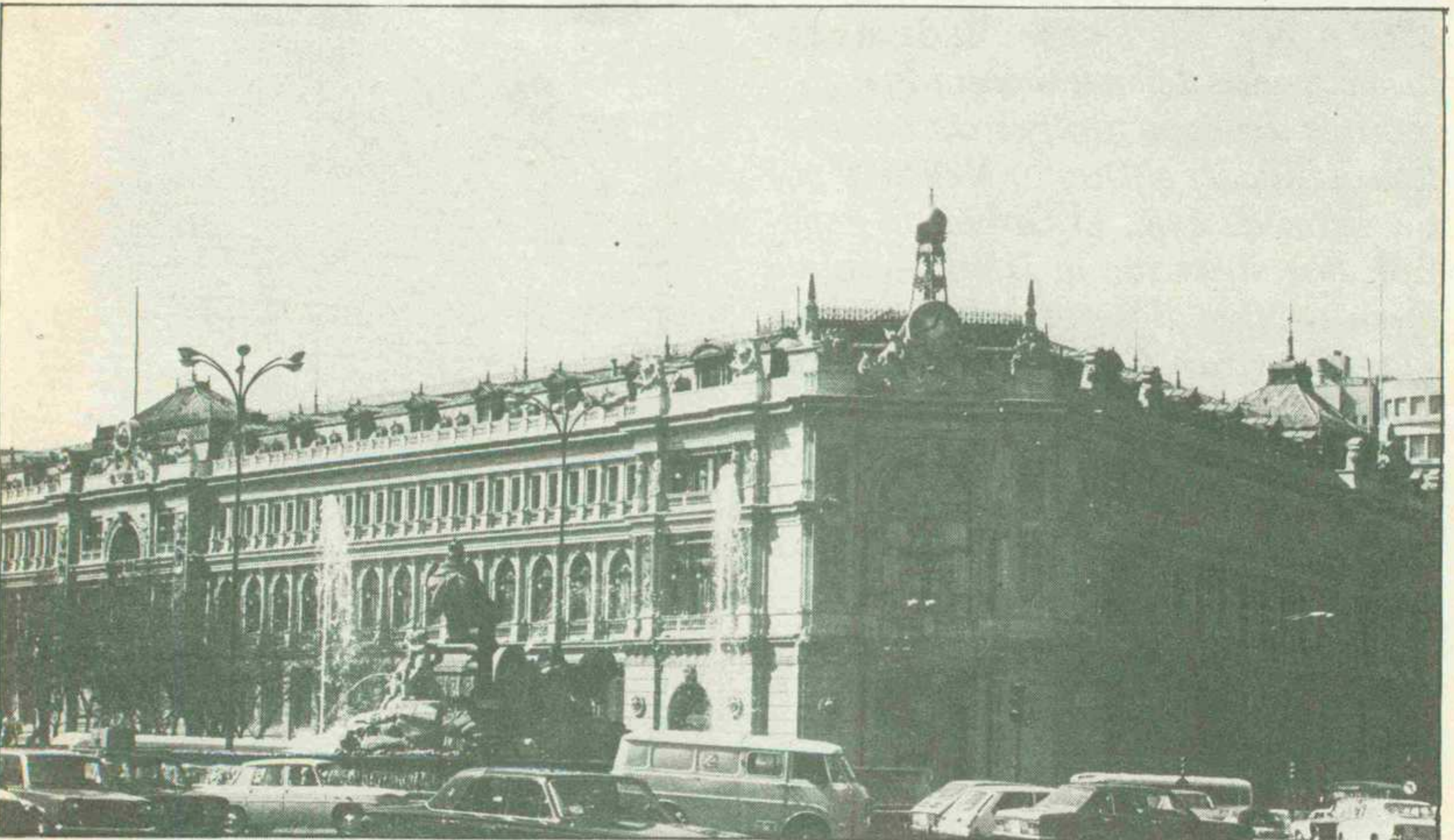
Todo el « affaire » empezó cuando, en 1931, el Banco de España (organismo privado pero relacionado con el Estado español en cuanto a emisiones monetarias, y cuyo edificio aparece en la imagen) obtiene un préstamo de 1.115 millones por parte del Banco de Francia, recibiendo éste como contraprestación 1.500 millones de francos en oro.
